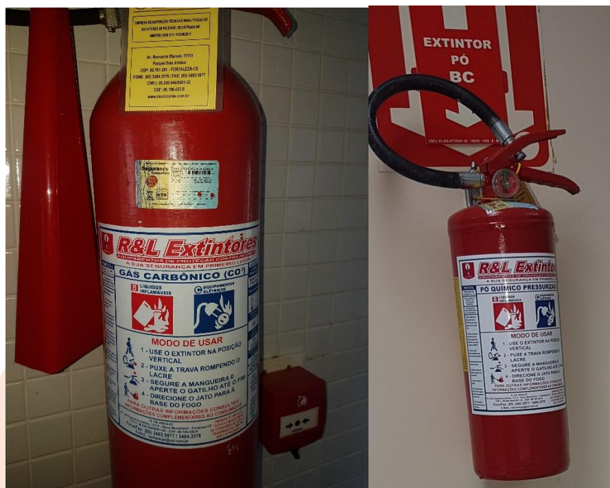
Figura 17. Extintor inadequado para classe de fogo BC– Sistema de Extintores.
