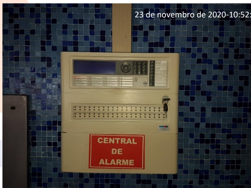
Figura 26. Central de alarme inoperante.
