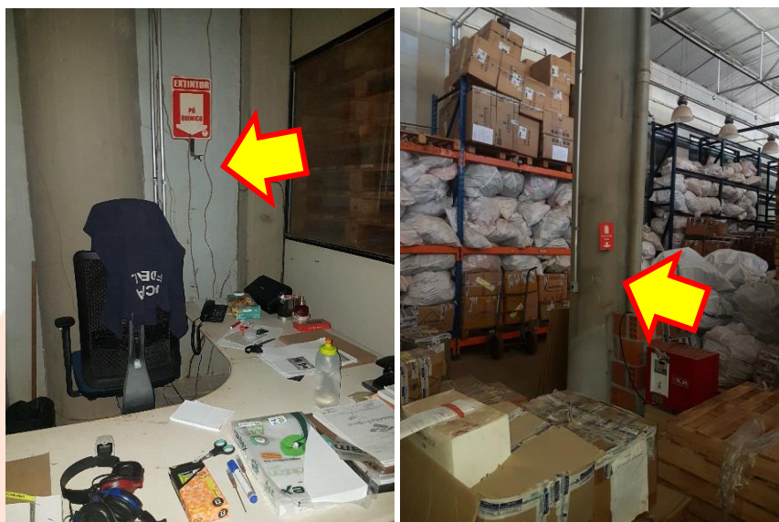
Figura 19. Falta de cobertura – Sistema de Extintores.
