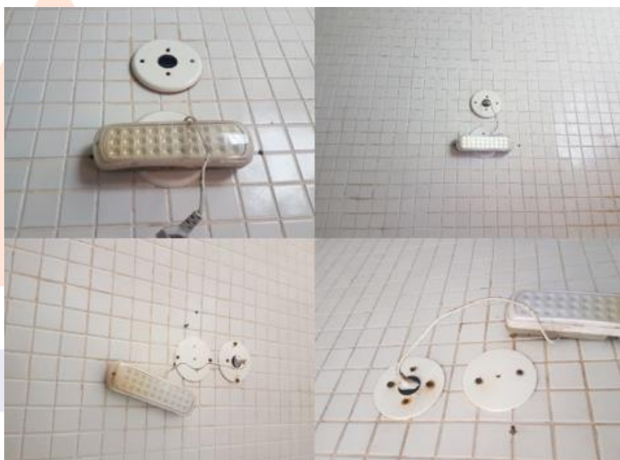
Figura 13. Luminárias de emergência com defeitos.
