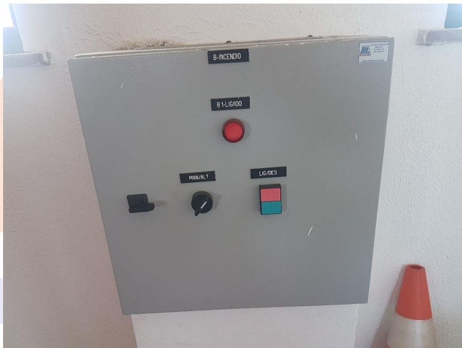
Figura 25. Painel de Comando da Bomba de incêndio.
