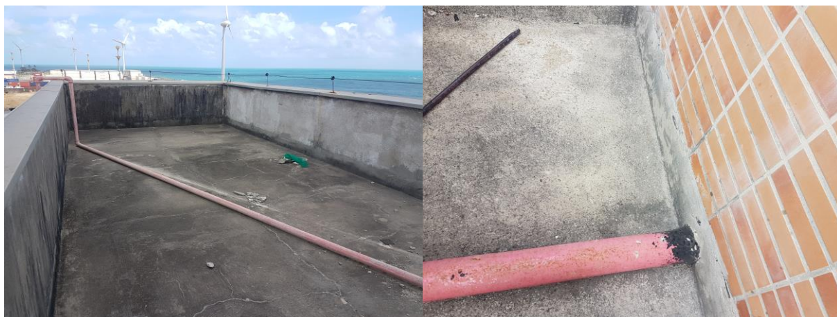
Figura 20. Tubulação com pintura danificada – Topo da caixa d'água e Coberta.
