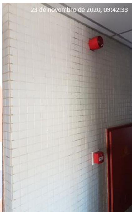
Figura 5. Ausência de sinalização de emergência – Sistema de Alarme de Incêndio.
