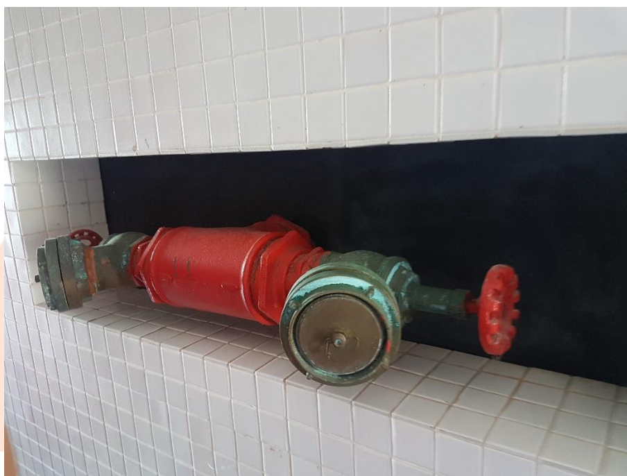
Figura 23. Adaptadores do Hidrantes - Diâmetro de 2 ½”.
