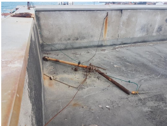
Figura 28. Sistema de Captação danificado por corrosão.
