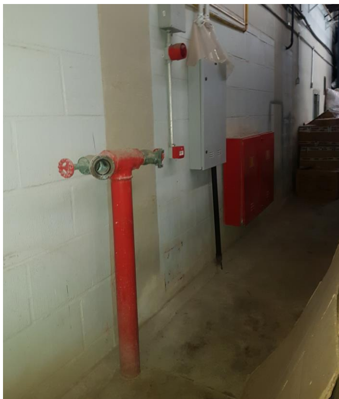
Figura 7. Ausência de sinalização de emergência – Sistema de hidrantes.
