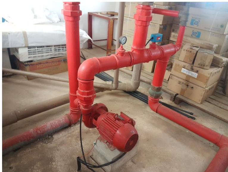
Figura 24. Bomba de incêndio de .
