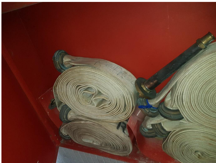
Figura 22. Armário de Mangueiras – Diâmetro de 2 ½”.
